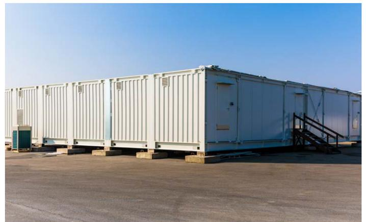
*Dimension Data: sistema de data center de alta qualidade pré-fabricado e modular, com conformidade Tier III, que foi pré-fabricado, integrado e testado nas instalações da Vertiv na Europa. Foi então desmontado e embalado em 12 unidades separadas para embarque, embaladas para o transporte e fizeram a jornada para a África do Sul, onde foram remontadas no site com o data center pronto para teste em menos de 6 semanas.*
