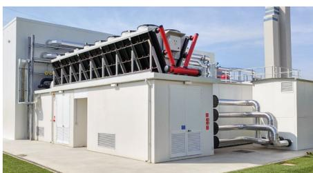
L'ultimo Lab è in grado di testare unità con capacità di raffreddamento fino a 1.5 MW, con un'elevata precisione in un'ampia gamma di condizioni di lavoro, da -10°C a +55°C, anche per le unità adiabatiche.
