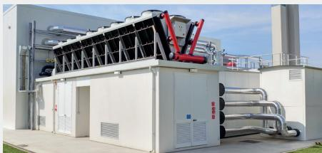
Ce laboratoire récemment conçu peut tester des unités ayant des puissances frigorifiques jusqu'à 1,5 MW avec une précision de pointe dans une large variété de conditions de fonctionnement, de -10 °C à +55 °C, idem pour des unités adiabatiques.
