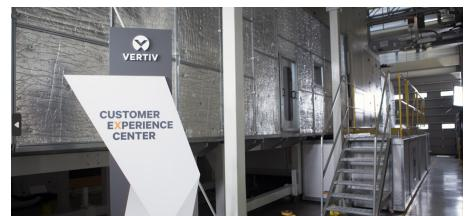
Espace dédié pour tester le Liebert EFC, l'unité de freecooling par évaporation indirecte à haute efficacité de Vertiv. Les paramètres de test intègrent des charges IT allant jusqu'à 450 kW et un débit d'air allant jusqu'à 120 000 m<sup>3</sup> par heure, quelle que soit la température ambiante extérieure requise pour simuler les conditions de pointe typiques que l'on peut rencontrer dans l'ensemble de la zone EMEA.
