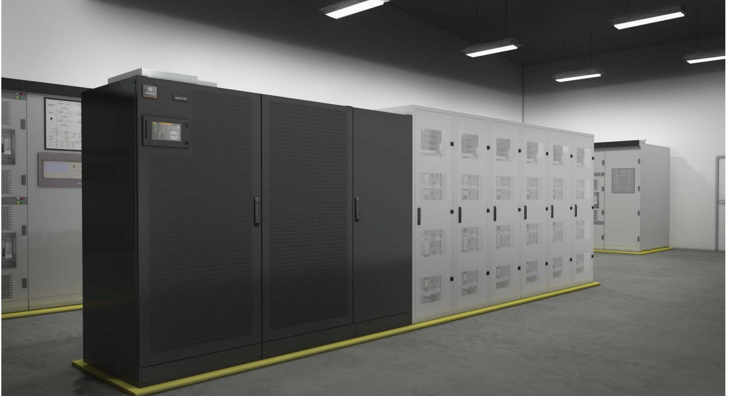
*Gabinets de baterías de iones al lado de un UPS de 1200 kW*
