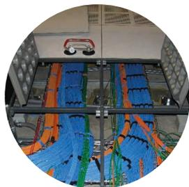
Para alojar las grandes longitudes de cableado necesarias para distribuir la potencia del punto A al punto B, los centros de datos pueden adoptar un diseño con piso elevado o bandejas portacables aéreas.
