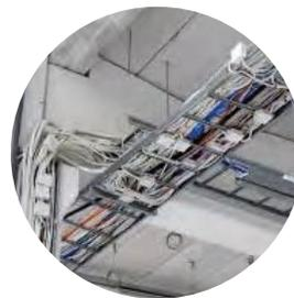
Sin embargo, en aplicaciones con una altura limitada del espacio o equipo pesado, el acceso al piso elevado no siempre es una opción viable. Una práctica alternativa es crear conductos aéreos para el cableado por medio de bandejas portacables que se montan por encima de los racks o se suspenden del cielorraso.
