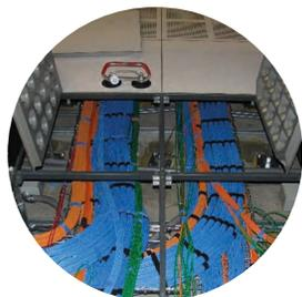
Para acomodar as grandes extensões dos cabos necessários para distribuir energia do ponto A para o ponto B, os data centers podem ser projetados com um acesso por piso elevado ou com trilhos de cabos suspensos.
