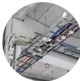
Entretanto, em aplicações com altura da sala limitada ou equipamentos pesados, o acesso por piso elevado pode não ser uma opção viável. Uma prática alternativa seria criar uma trajetória aérea de cabos através de calhas montadas sobre os rack ou suspensas a partir do teto.
