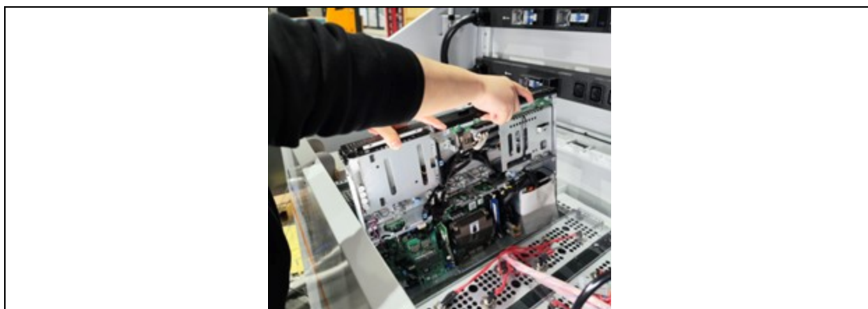
Figura 7.8 Sollevamento del server
