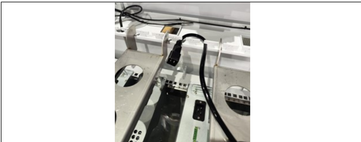
Figura 7.7 Fissare i cavi di alimentazione e dati del server
