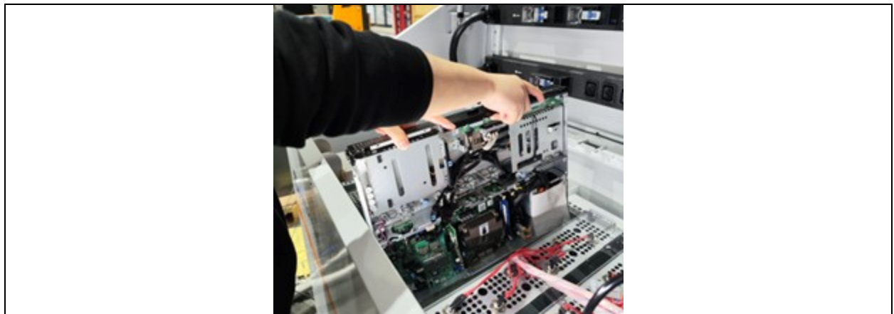
Abbildung 7.8 Anheben des Servers
