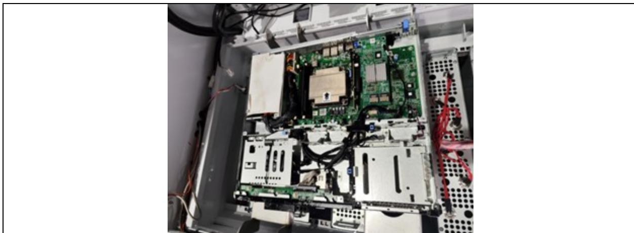
Figure 7.9 Mise en place du serveur sur le rail de guidage
