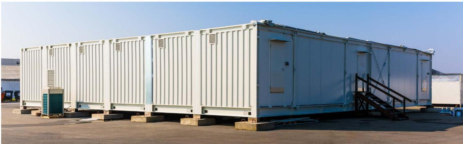
*Dimension Data*：在 Vertiv 歐洲工廠預裝、整合和測試的高品質預裝式模組化 Tier III 資料中心系統。然後將其拆卸成 12 個可裝運的單元，運輸包裝，然後前往南非，在現場重新組裝，準備在 6 周內進行測試。
