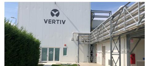
In diesem neu konzipierten Labor können bis zu 400 kW und 100.000 m<sup>3</sup>/h bei Betriebsbedingungen zwischen +10 °C und +50 °C getestet werden.
