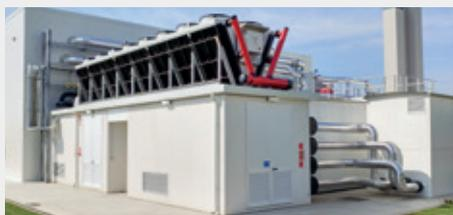
Ce dernier laboratoire conçu spécialement peut tester des unités avec des capacités de refroidissement allant jusqu'à 1,5 MW avec une précision de pointe dans une large gamme de conditions de travail, de -10 °C à +55 °C, et cela également pour des unités adiabatiques.
