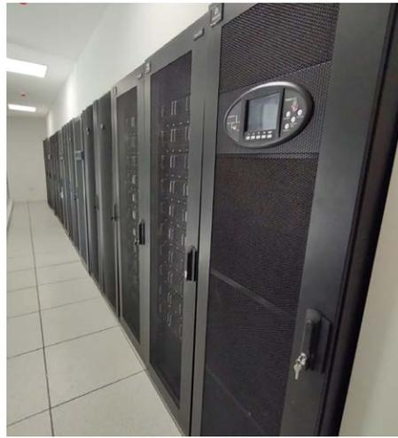
Fazer a engenharia do novo data center da Nini não foi uma tarefa simples. Para começar, a equipe da Vertiv precisou garantir que o piso técnico suportasse o peso da unidade Liebert® APM que seria inserida em um rack de proteção. Após os cálculos de peso, uma modificação estrutural garantiu que o piso pudesse suportar a solução de 1.200 quilos.
