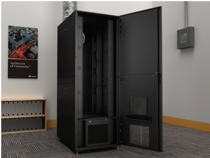
Installation en rack à 4 montants dans un rack à séparation thermique - solution Vertiv™ VRC-S
